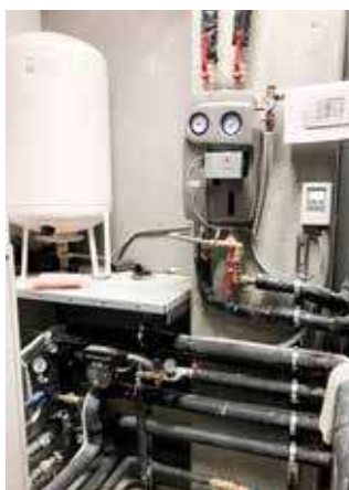
La centralina solare è dotata di un sistema di messa in funzione che guida l'utente nella scelta rapida ed efficace delle impostazioni
